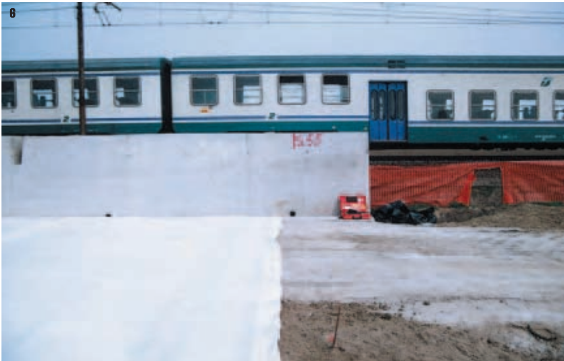
6. Il muro di contenimento tra il vecchio e il nuovo binario e il geocomposito drenante Interdrain GMG752
