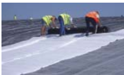
Instalación de INTERGRID 80/30 en los taludes del Vertedero.
