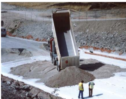
Figura 8. Durante la construcción, los geocompuestos drenantes reciben cargas muy importantes.
