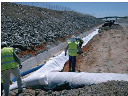
Figura 10. Instalación del sistema VIADRAIN
