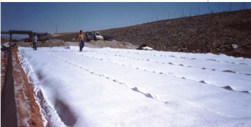
Figura 5. Drenaje de estabilización de la plataforma.
