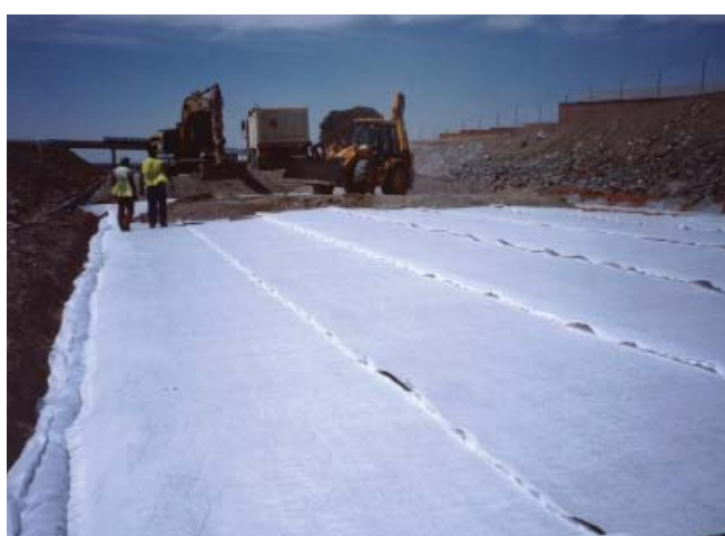
Figuras 13 y 14. Operaciones de extendido y compactación de la capa de forma.
