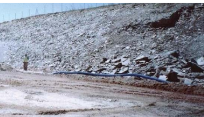
Figura 1. Presencia de agua en el fondo de la excavación.
