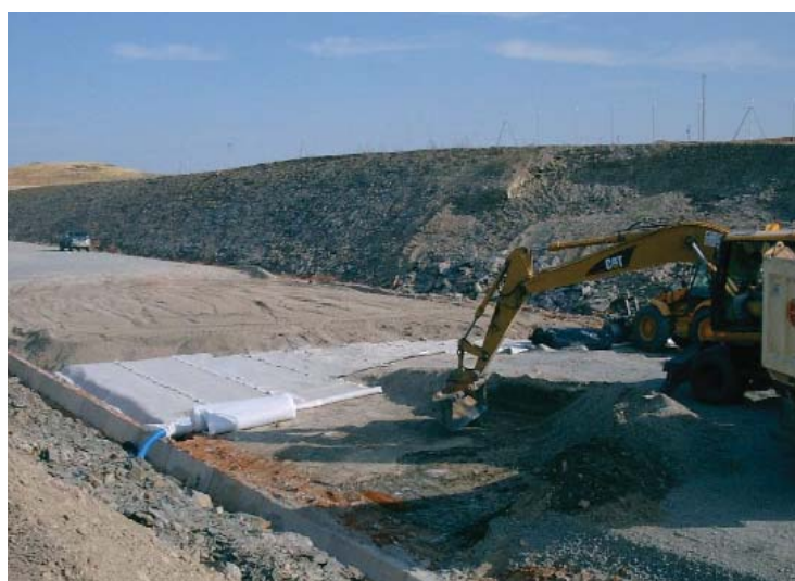
Figuras 11 y 12. Colocación de los rollos de INTERDRAIN
