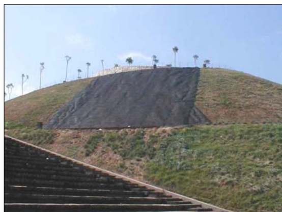
Instalación de malla volumétrica
